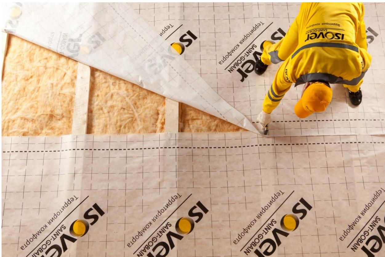
Монтаж мембраны ISOVER VS 80 следует осуществлять ворсистой стороной к теплоизоляции. Сторона с логотипом ISOVER должна быть обращена в сторону помещения.
